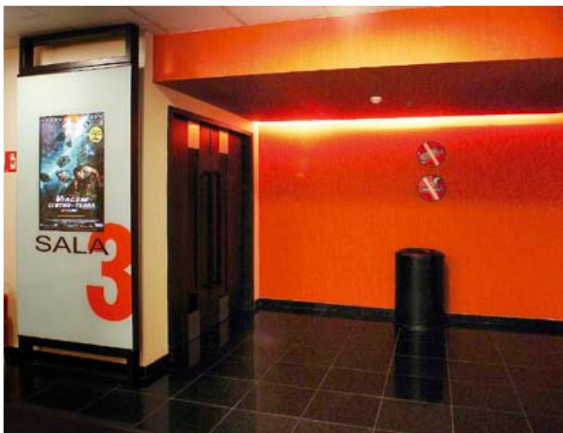
Cinemark São Paulo. Parede Corta-Fogo entre sala de projeção e hall de acesso. Arq. Conrado José Garcia Ferres. ©2008 - Banco de imagens Gypsum Drywall.
